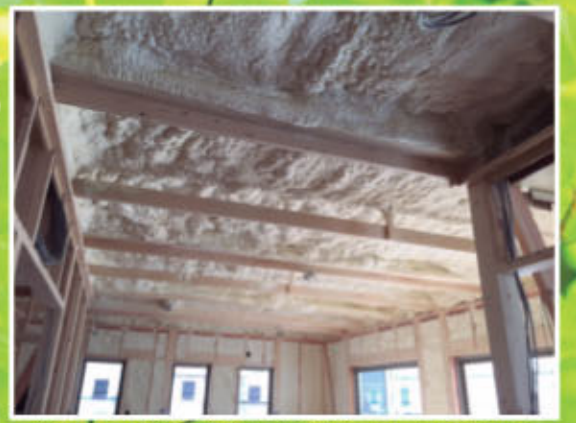
ウレタン発泡吹付断熱材で、夏は涼しく冬はポカポカ暖か!!
