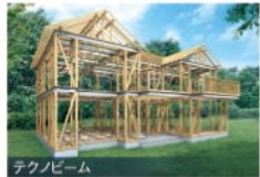
テクノビーム 木と鉄の複合梁「テクノビーム」で木造住宅を強化
